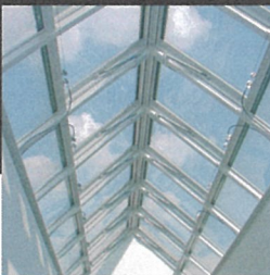
自然採光を取り入れるトップライト
