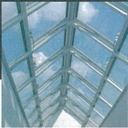
自然の光を取り入れるトップライト
